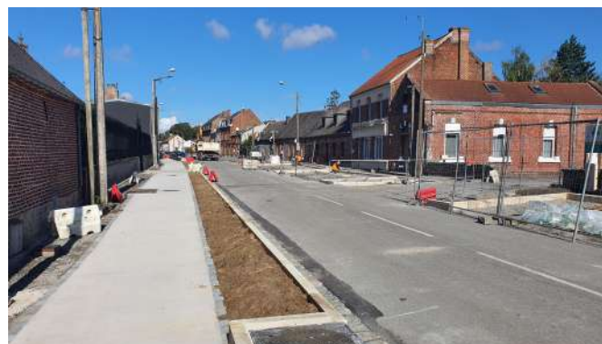
Requalification du faubourg Fauroeux
