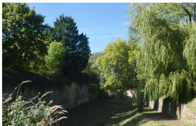
Remparts sud, AEI, octobre 2021
