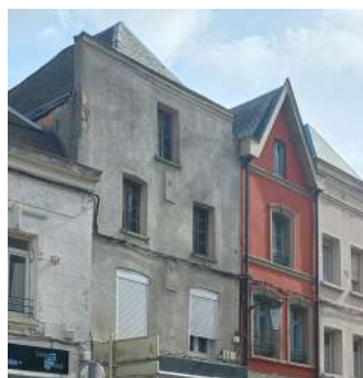
Façade cachant la toiture à croupe
