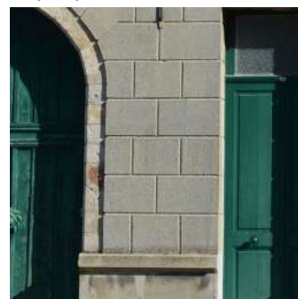
Enduit - Dessin d'appareillage façon pierre
