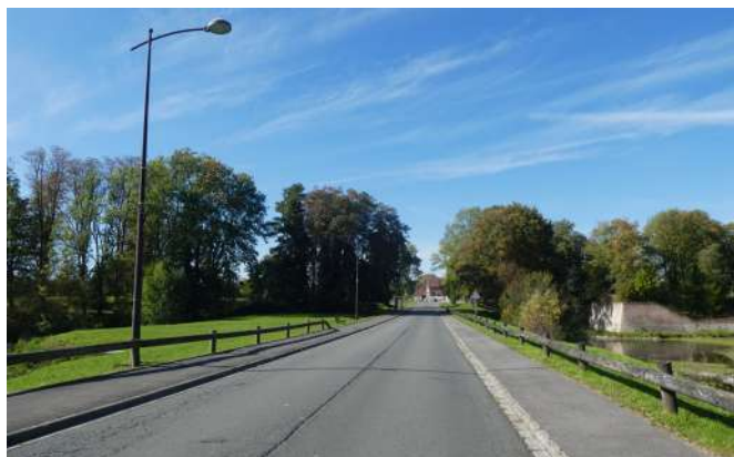
Avenue de la Libération - Ouverture de l'axe nord-ouest de la ville
