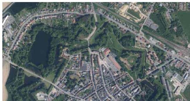
rempart nord, vue aérienne 2021, Géoportail
