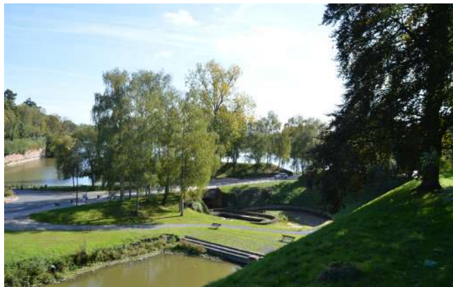
Déversoir de l'étang du Pont Rouge
