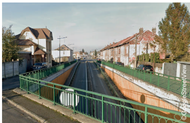
20 - Tunnel route de Valenciennes
