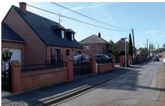
13 - Route de Lorgines
