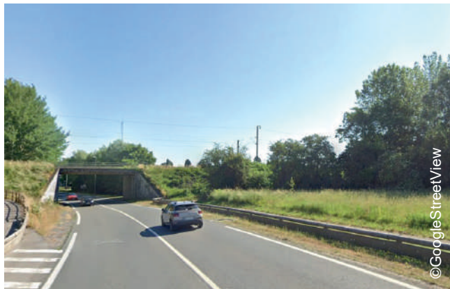
4 - Route départementale D934
