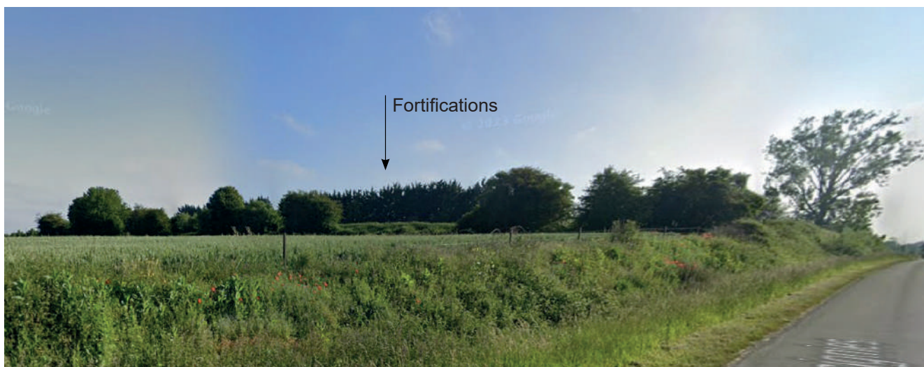
2 - Route départementale RD934
