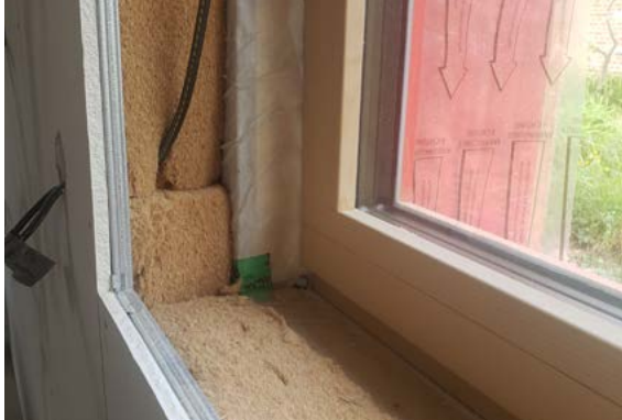
➤ Travaux d'amélioration énergétique du logement
