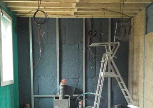
➤ Rénovation lourde de l'habitat
