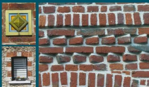
Exemples de mise en œuvre décoratives de maçonneries en brique : faïence, harpage, pose des briques très travaillée.
