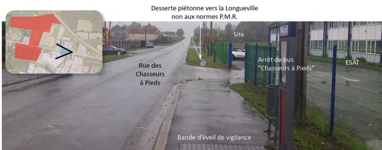
Vue 5 – Disparité de la continuité piétonne PMR du site vers le noyau villageois par la rue des Chasseurs à Pieds
