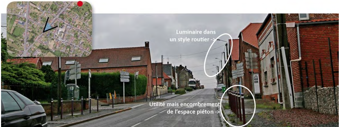
Vue 3 – A 350 mètres par le sud-ouest
