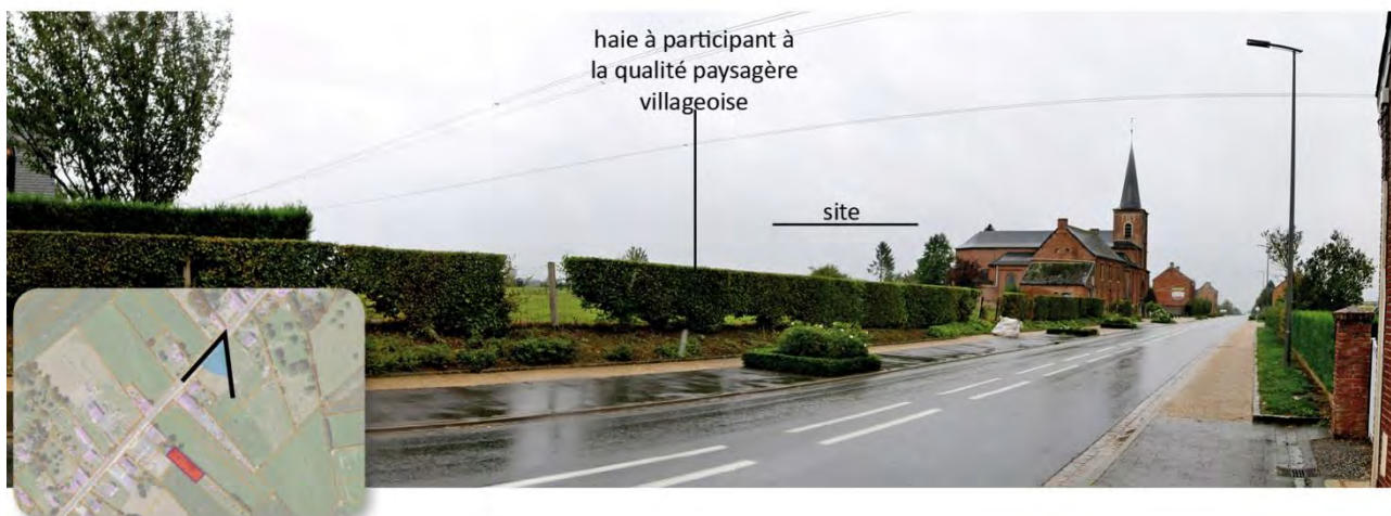
Vue 1 – Approche nord du site par la RD932
