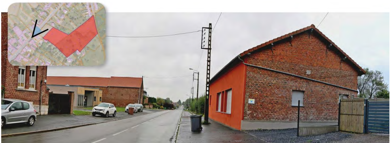
Vue 4 – Approche immédiate par le sud-ouest
