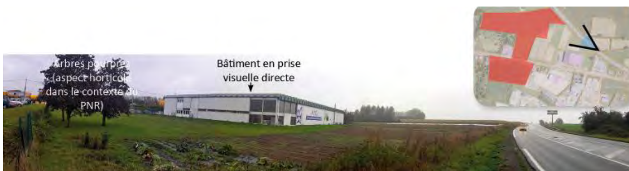
Vue 5 – Parcelle de l’ESAT depuis la RD649
