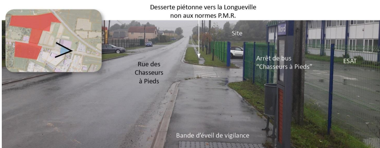
Vue 5 – Disparité de la continuité piétonne PMR du site vers le noyau villageois par la rue des Chasseurs à Pieds
