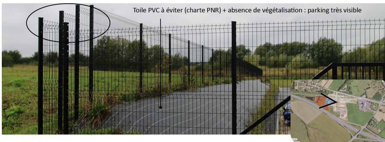
Vue 13 – arrières sud du bâtiment d'entrée de site.
