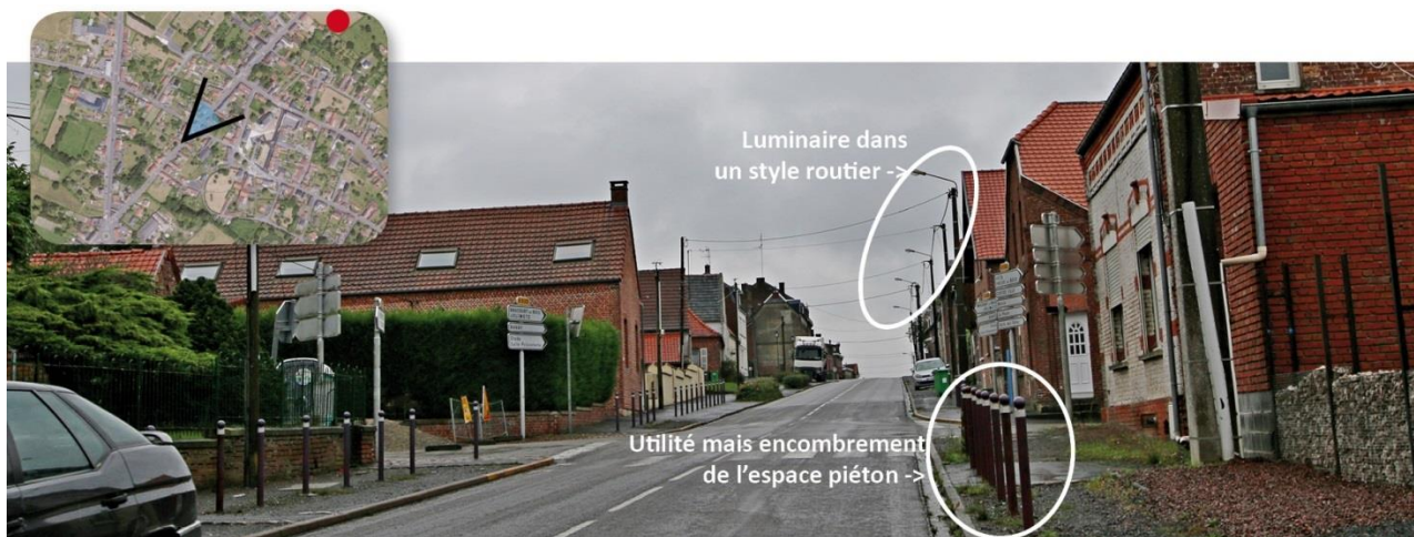
Vue 3 – A 350 mètres par le sud-ouest
