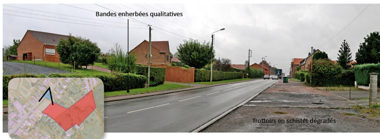
Vue 2 – Proche au nord-est de l'opération
