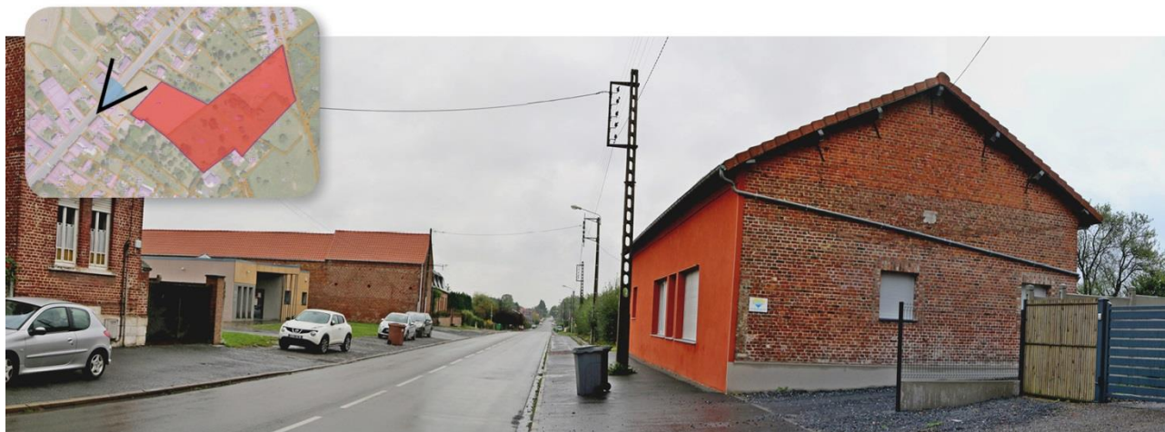
Vue 4 – Approche immédiate par le sud-ouest
