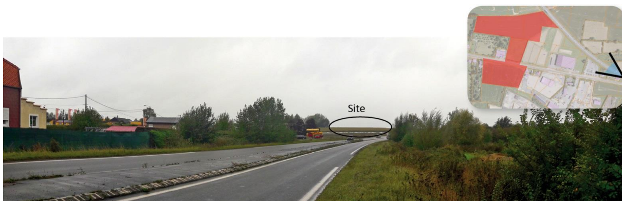
Vue 3 – Approche sud-est par la RD649
