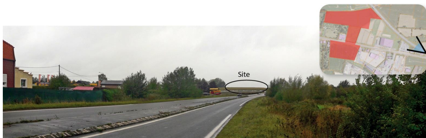
Vue 3 – Approche sud-est par la RD649
