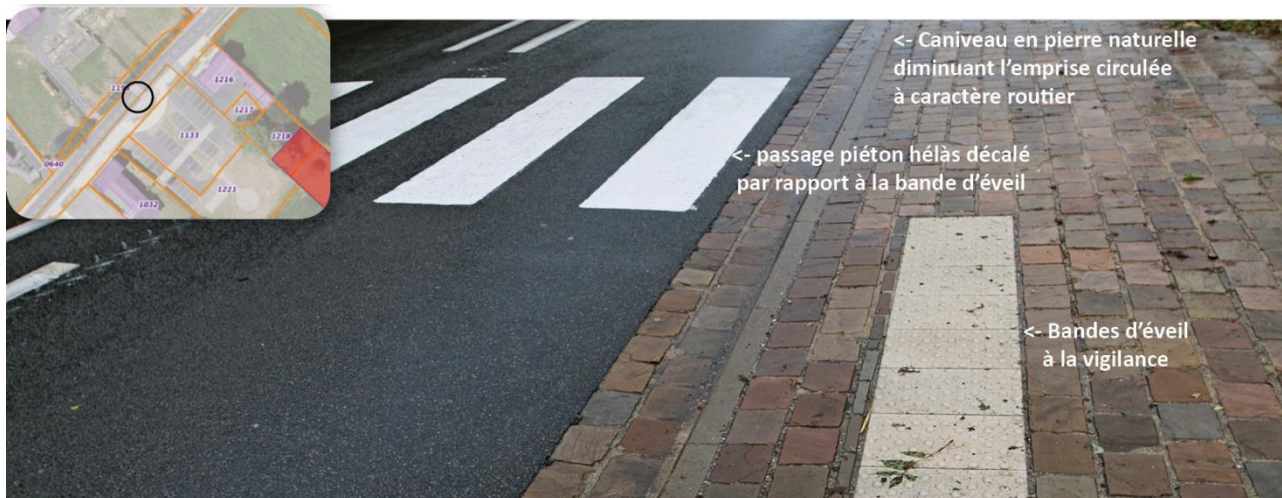
Vue 3—passage piéton sur la RD932 au sud-est de l'église
